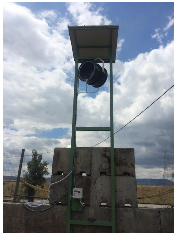
Obr. č. 3 – nosná konstrukce ventilátoru
