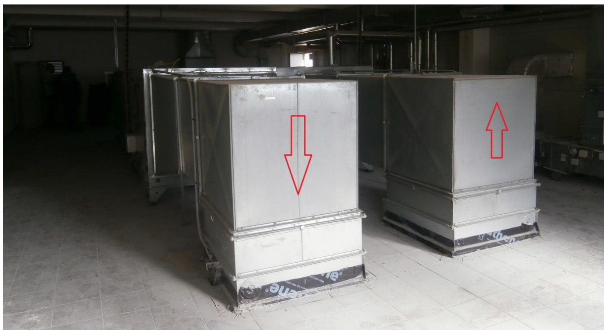
Přívod čistého vzduchu obohaceného o aktivní látky Biothys™ a odtah vzdušiny z vnitřního prostoru budovy (cca 10 000 m 3 ) po redukci zápachu
