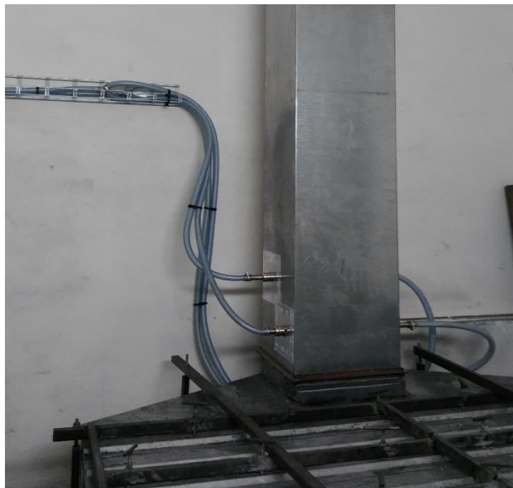
Zavedení perforovaných trubíc do vzduchotechniky
