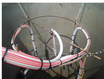
Napojení tlakových hadic, zakončené tryskami
