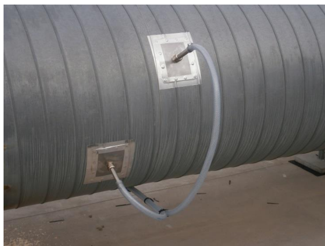
Zavedení perf. trubice do vzduchotechniky
