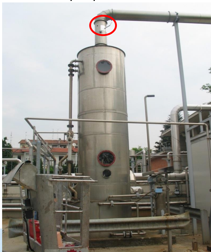
Skrubr: zavedení první perforované trubice
